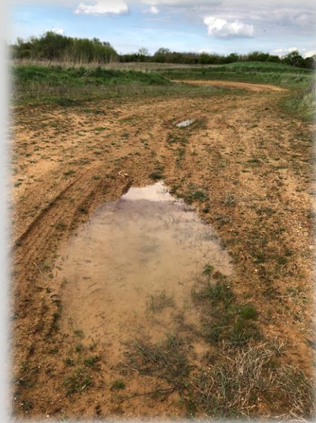
Photo 21 : Exemple d'ornière fonctionnelle laissée en l'état (haut) et à restaurer (en bas)
