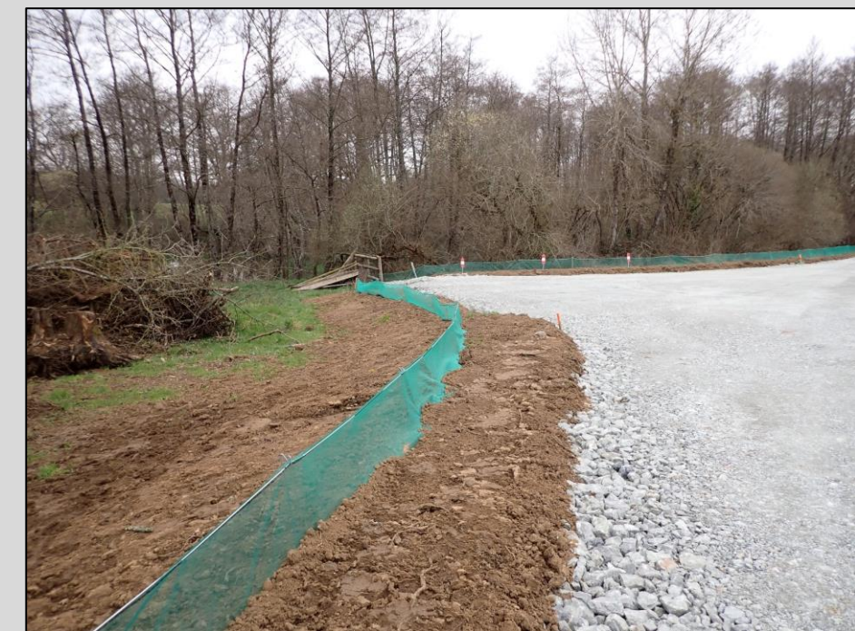
Photo 20 : Illustration de la clôture anti-retour « amphibiens » (sans rampe sur cet exemple)
